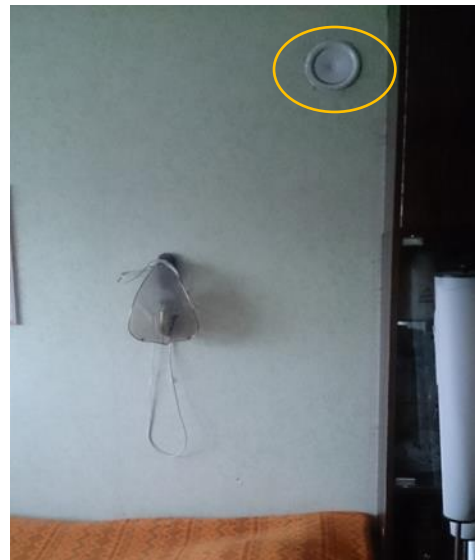
Joonis 4.9 Korterite erinevate tubade vahelised siseuksed (eriti köökidel ja sanitaarruumidel) on õhutihedad ja siirdeõhk ei saa ruumide vahel liikuda (vasakul). Otse voodi kohal paiknev õhusuunajata plafoon on kinni keeratud (paremal)
