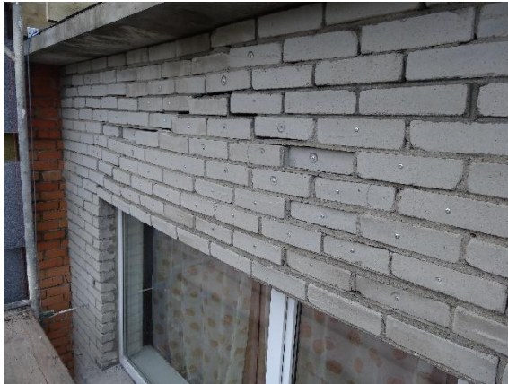
Joonis 5.7 Lõik seletuskirjast Kolmandal korrusel esineb tellisemüüritise välimise kihi vajumist (vajalik lisaankurdamine või ümberladumine) on liiga üldine ega kajasta probleemi olulisust. Iga kivi lisaankurduse asemel (vasakul) tuleb seiniosa lammutada (paremal) ja uuesti ehitada. Selline kirjeldus on eelprojekti tasemel, ei anna piisavat infot põhiprojekti otsuste tegemiseks, kuna erinevatel lahendustel on erinev maksumus ja teostuse aeg
