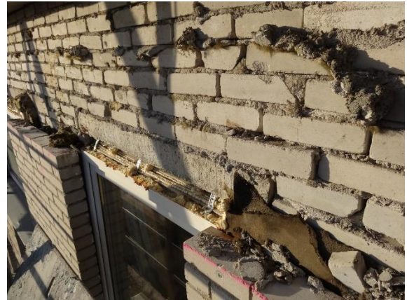
Joonis 5.7 Lõik seletuskirjast Kolmandal korrusel esineb tellisemüüritise välimise kihi vajumist (vajalik lisaankurdamine või ümberladumine) on liiga üldine ega kajasta probleemi olulisust. Iga kivi lisaankurduse asemel (vasakul) tuleb seiniosa lammutada (paremal) ja uuesti ehitada. Selline kirjeldus on eelprojekti tasemel, ei anna piisavat infot põhiprojekti otsuste tegemiseks, kuna erinevatel lahendustel on erinev maksumus ja teostuse aeg
