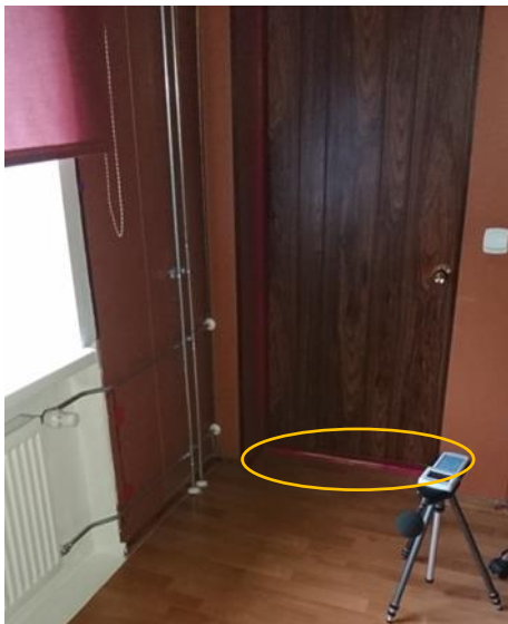
Joonis 4.9 Korterite erinevate tubade vahelised siseuksed (eriti köökidel ja sanitaarruumidel) on õhutihedad ja siirdeõhk ei saa ruumide vahel liikuda (vasakul). Otse voodi kohal paiknev õhusuunajata plafoon on kinni keeratud (paremal)
