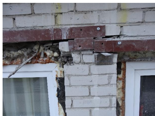
Joonis 5.8 Ehitusprojektist (vasakul) ei selgu uue silluse toetamise lahendus. Avatäidete ümbruse lõikamisega on välisseina kandevõime nõrgestatud (paremal)
