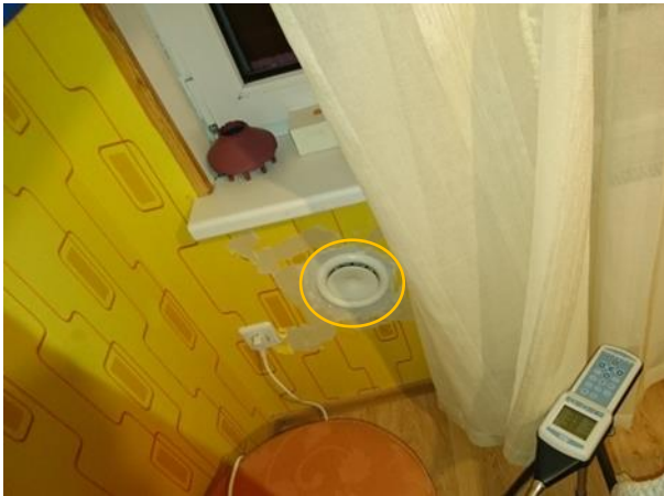
Joonis 4.8 Sissepuhkeplafoon on paigaldatud välisseina alumisse ossa radiaatori kõrvale, kasutatud on ilma joasuunajata plafooni (vasakul). Ilma joasuunajata plafoon on paigaldatud lapse voodi kohale (paremal)
